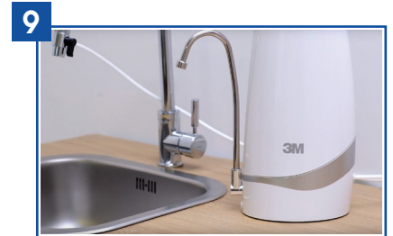
9. ติดตั้งเสร็จ พร้อมใช้งาน
